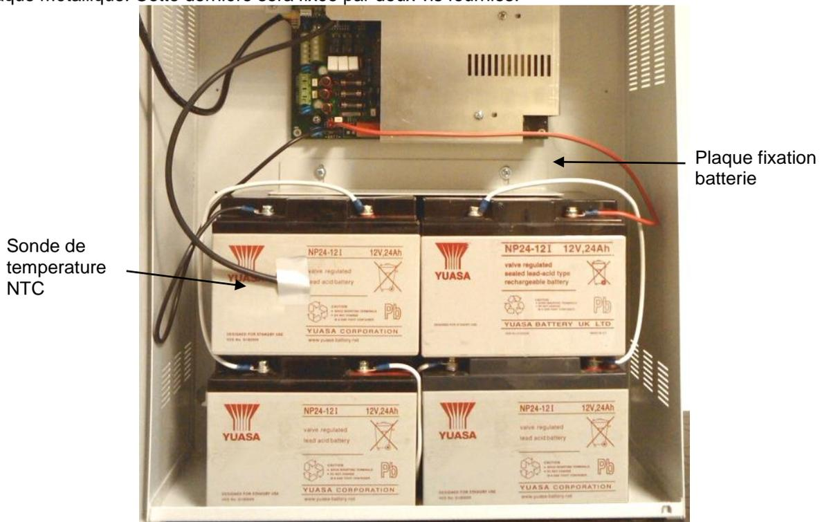
La connexion avec les batteries sera faite par deux conducteurs (rouge / noir) qui permettent d'assurer la charge des batteries et l'autonomie en cas de perte secteur. Les conducteurs sont fournis en version coffret avec faston d'une côté et œillets de l'autre.
