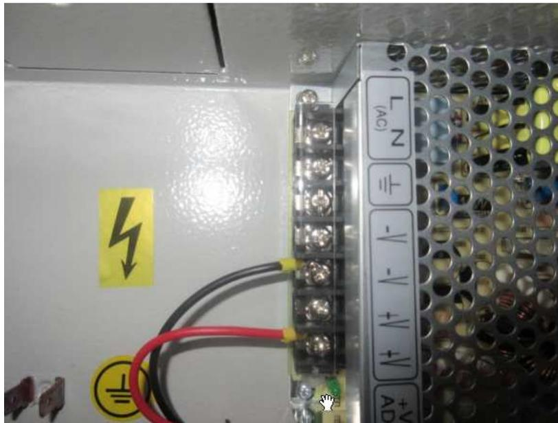
La partie centrale du CMSI doit être reliée à la terre électrique. Cette terre doit être dédiée aux matériels signaux faibles : « **Terre informatique** » selon le plan A4973RS.
